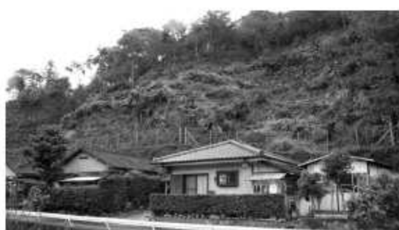
慰霊塔公園急傾斜地現場
