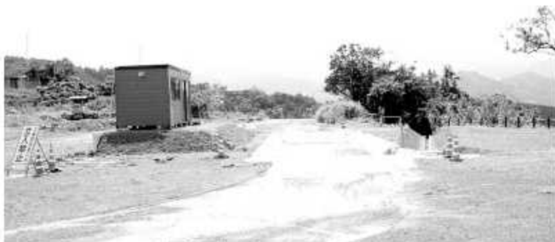
改良中の御立岬公園埋立地進入路
