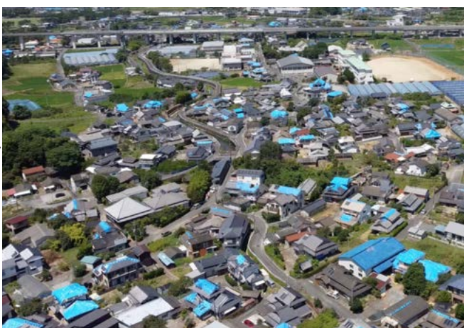
▶被災した住宅にブルーシート設置事業
