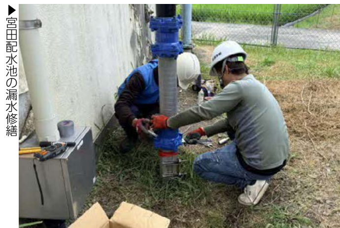
▶給水管の漏水修繕
