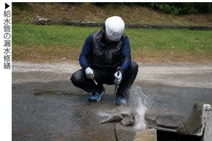
▶地中埋設配水管本管の漏水修繕
