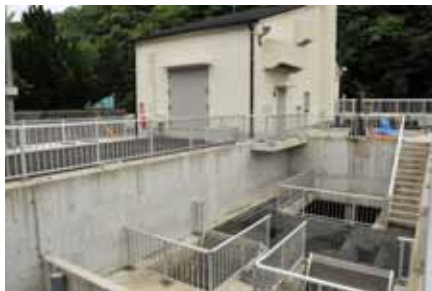
湯北地区排水機場完成 念願の排水機場が完成(5月17日)。計石、白岩地区でも完成
