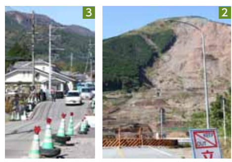
1_倒壊した拝殿(阿蘇神社) 2_崩落した阿蘇大橋と土砂崩れの跡(南阿蘇村) 3_地盤沈下で寸断された道路も現在は通行できる(阿蘇市)
