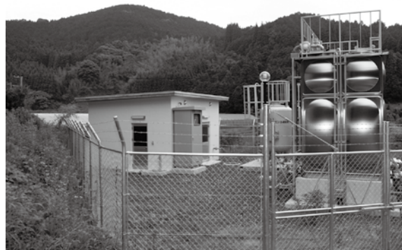
完成した女島水源地
