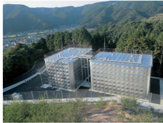
上水道施設（城山配水池）
