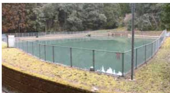
湯浦（橋本地区）の農業用ため池
