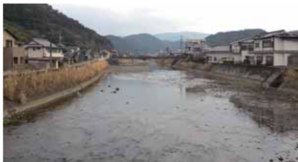
応急工事（河川掘削）が完了した湯浦川
