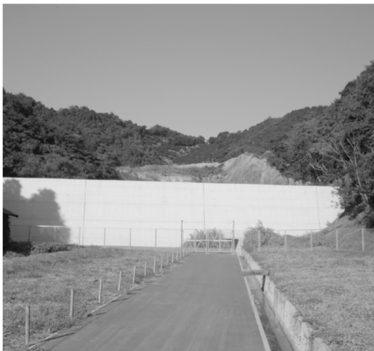
造成中の御立岬残土処理場
