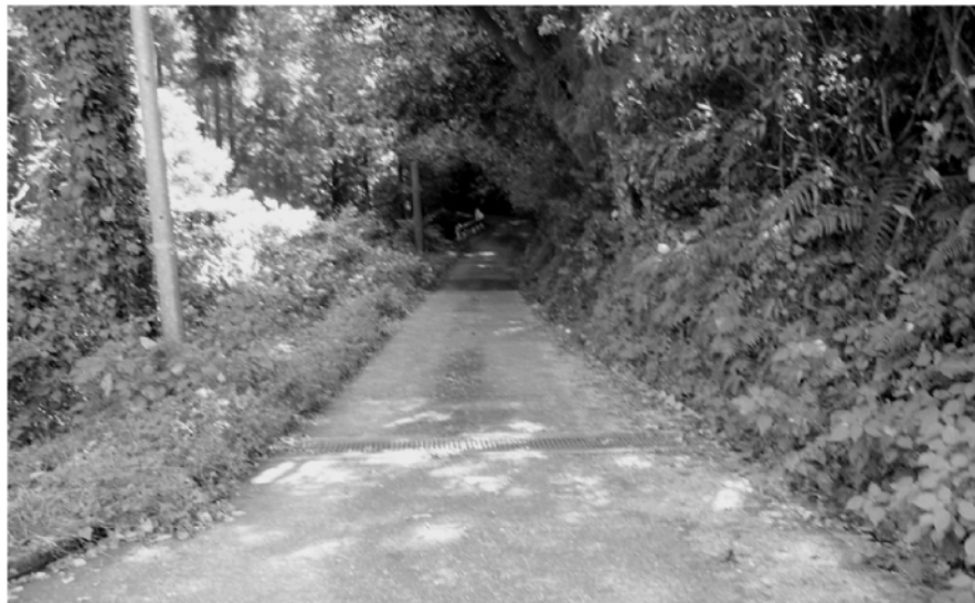
改良がまたれる町道熊ヶ倉岩尾戸線
