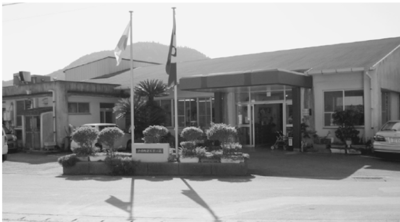
耐震診断を実施した老人ホーム
