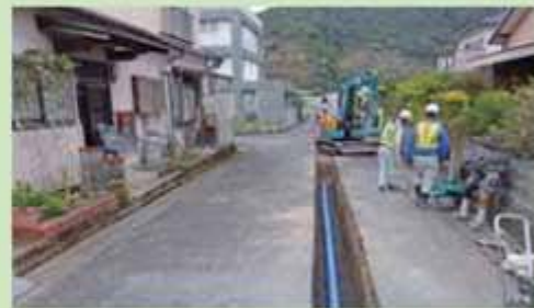
配水管布設替工事
