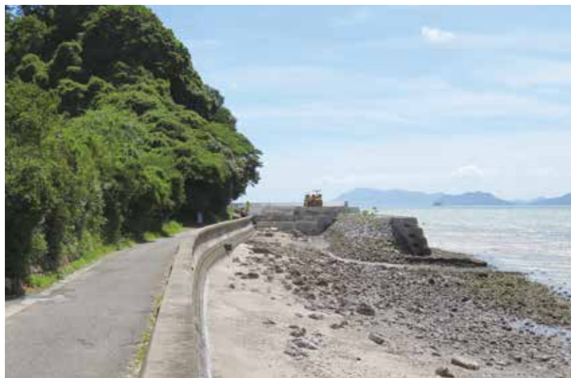
八代市側の護岸工事
