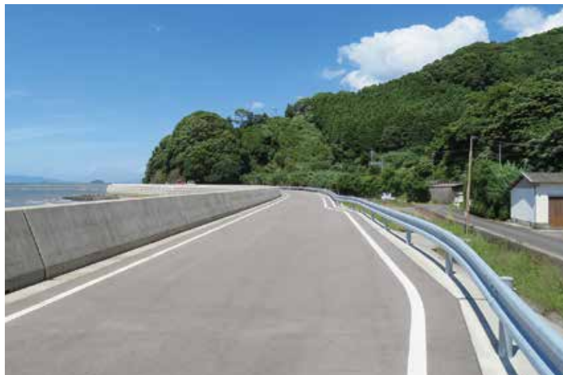
芦北町側の開通状況(井牟田・棕野地区)
