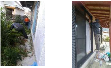
除草作業・室内清掃作業
