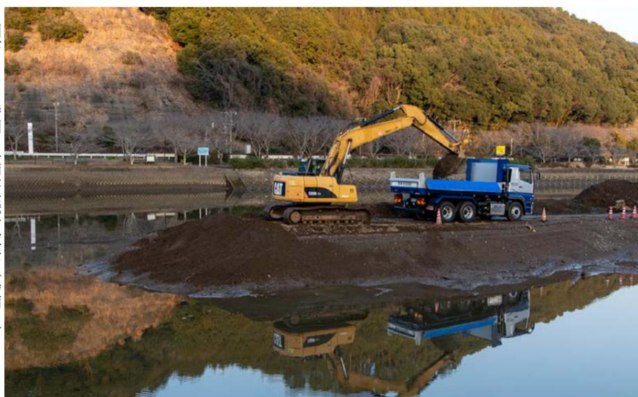
▶潮が引いた時間に大型重機で撤去(湯浦川)
