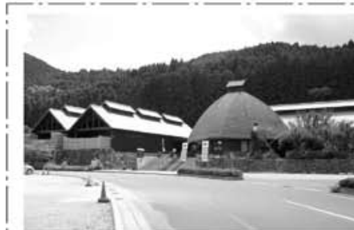
ボイラー修繕工事が完了した大野温泉センター
