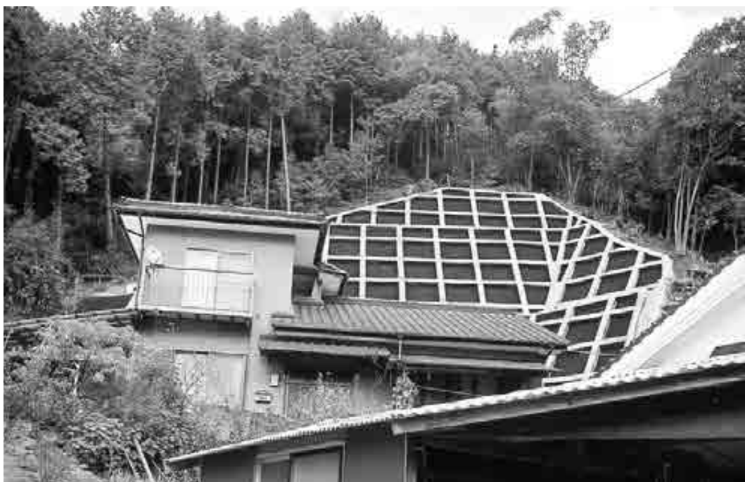
楮ヶ迫地区（丸米）の急傾斜地崩壊防止工事現場
