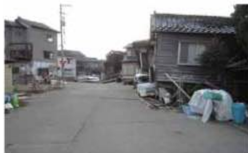
輪島市内の被災状況
