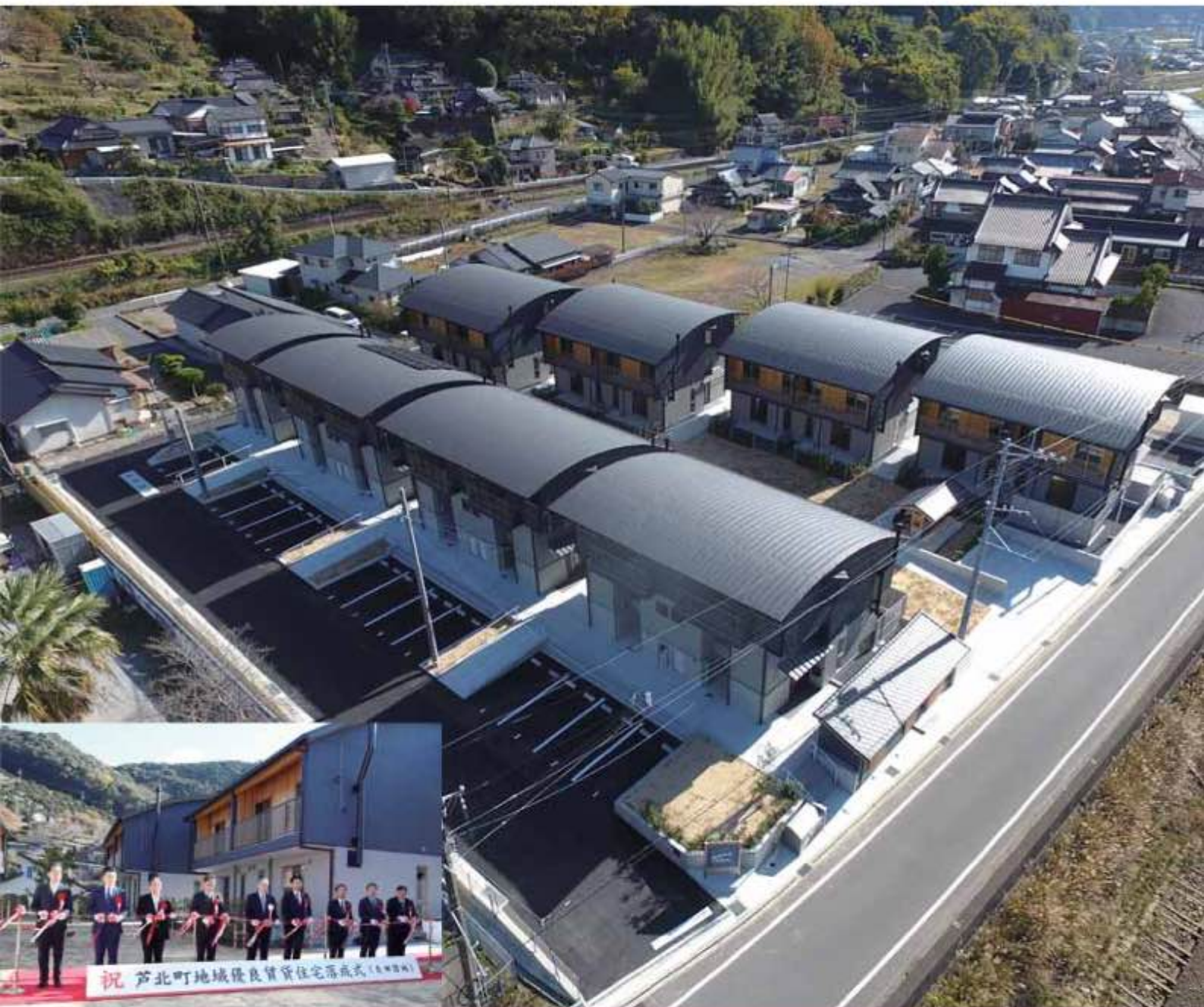
芦北町地域優良賃貸住宅・友田団地（湯浦）令和6年12月19日落成
