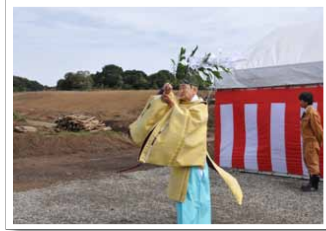
32.9haの広大な町有地に熊本県内最大規模の発電施設が完成します
