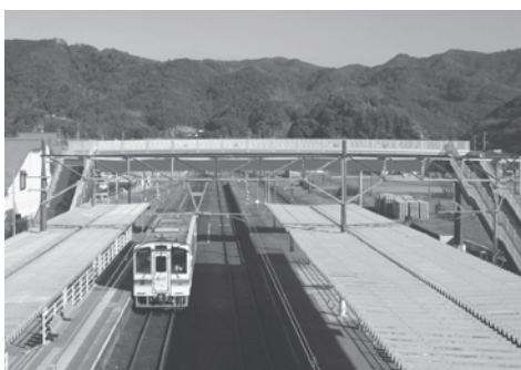
佐敷駅通路橋
