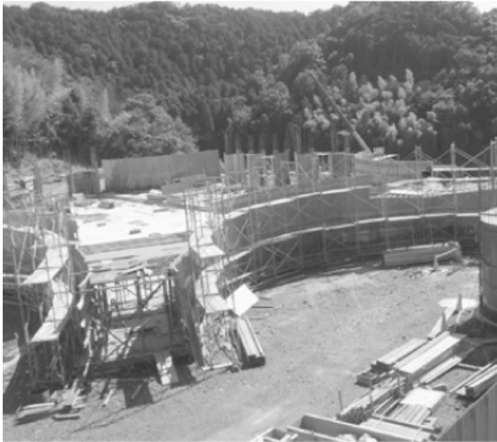
地域資源活用総合交流促進施設(サブ体育館)の建設状況
