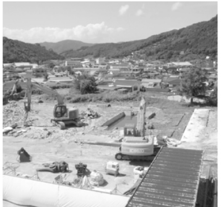
湯浦中学校体育館(解体状況)
