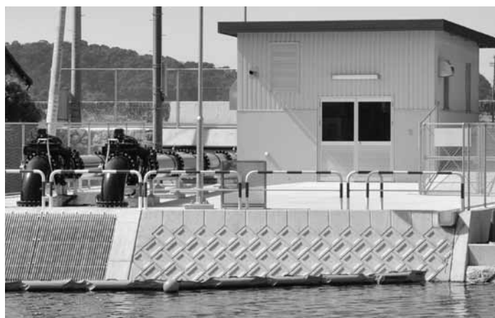
▲完成した排水施設
