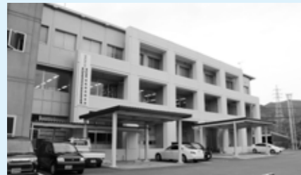
役場庁舎耐震補強工事
