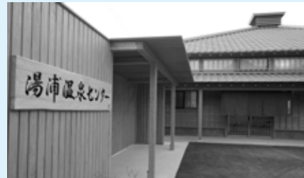
湯浦温泉センター改修事業
