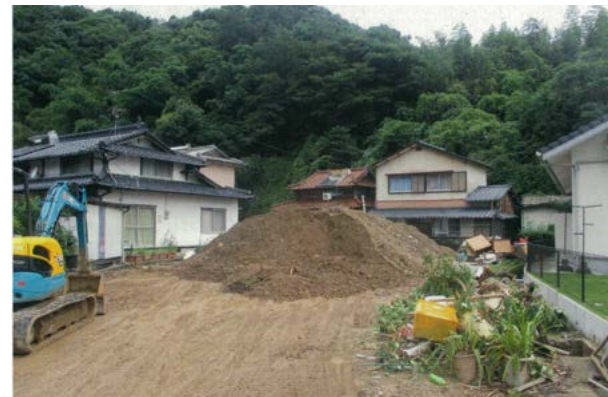
宅地内土砂撤去事業
