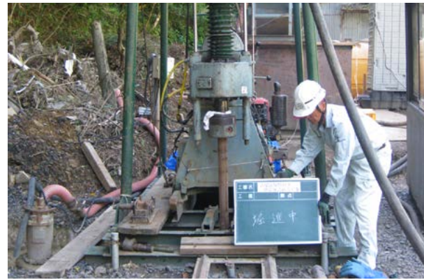
飲料水供給施設の復旧
