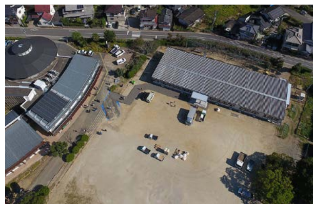
佐敷小学校仮設校舎完成
