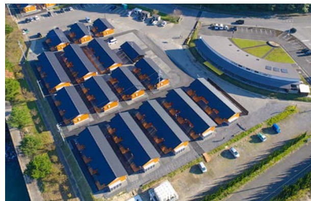
仮設住宅の完成
