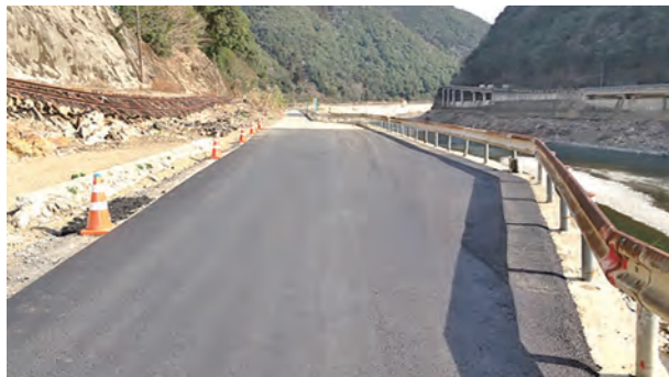
町道川嶽線（応急工事箇所）
