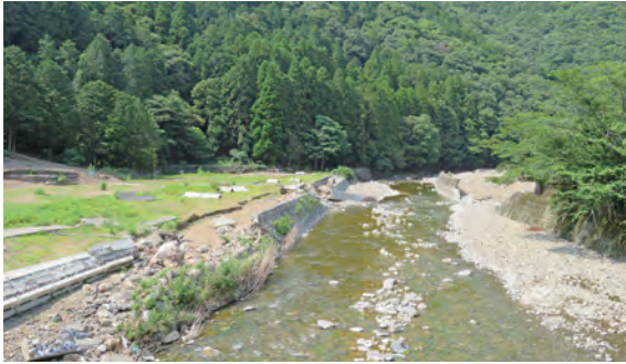
吉尾川(吉尾橋の下流付近)の災害状況
