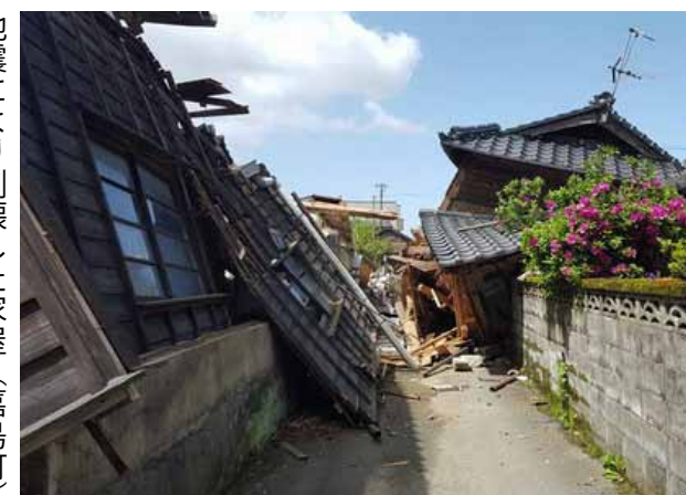
地震により倒壊した家屋（嘉島町）
