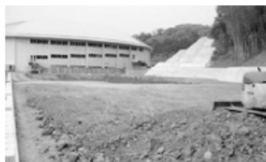
建設中の仮称第2体育館
