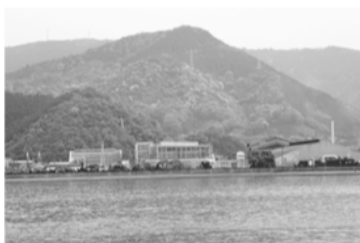
(株)東海カーボン田ノ浦工場
