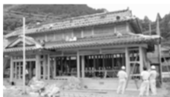
支援金を受けて建築中の町産材木造住宅
