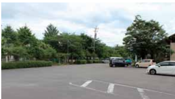
直売所舗装工事箇所（計石温泉センター周辺）
