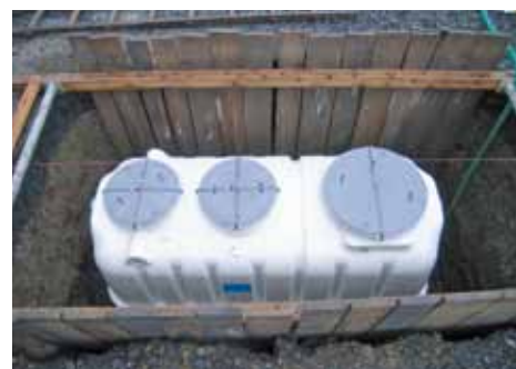
浄化槽設置整備事業
