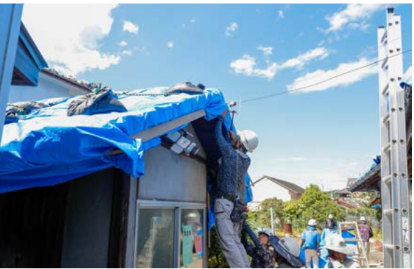
▶ブルーシートの展張工事
