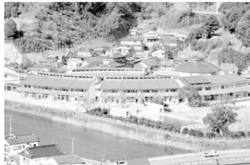
改築した佐敷小学校
