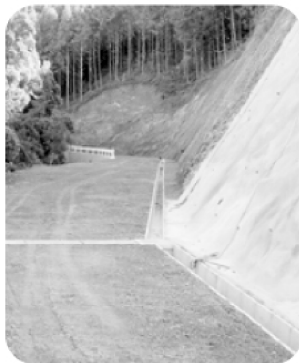
着々と工事が進む林道井牟田線
