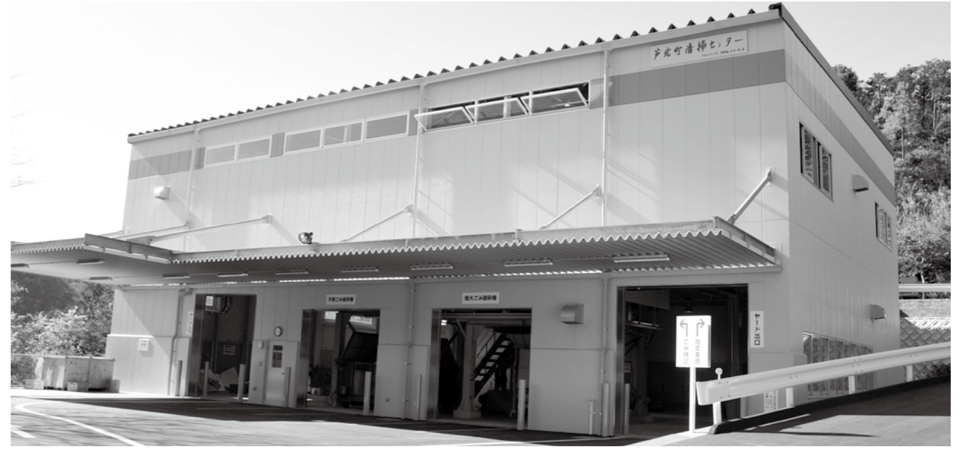
▲完成した2階建てのストックヤード(一時保管所)
