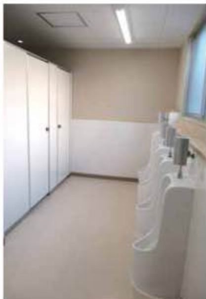
改修された田浦小学校のトイレ
