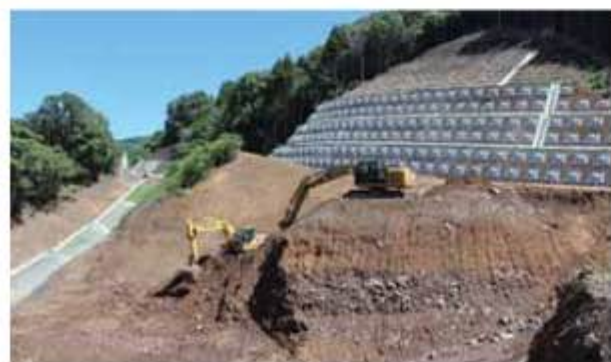
【広域農道鶴木山工区】改良復旧で施工中
