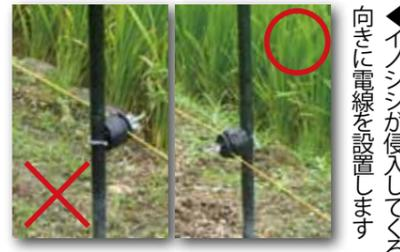
イノシシが侵入してくる向きに電線を設置します
