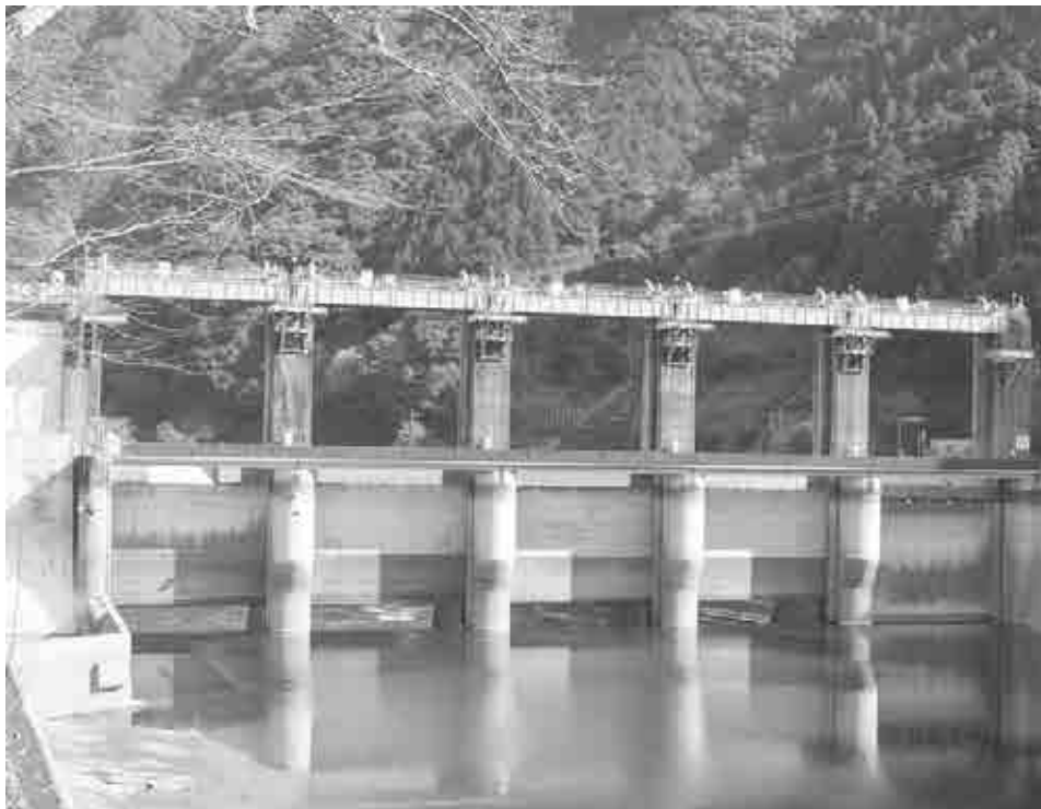
水位低下中の瀬戸石ダム
