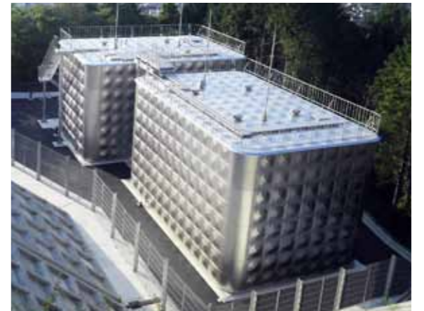
▼完成した配水池の全景
