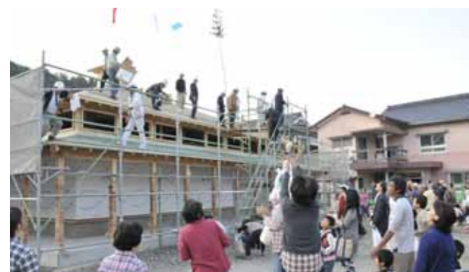
上棟式・餅投げが行われた湯浦温泉センター
