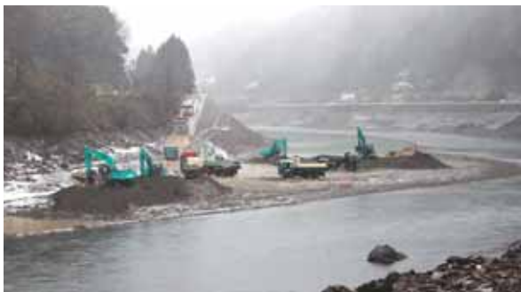
球磨川に堆積した土砂を運び出す様子
