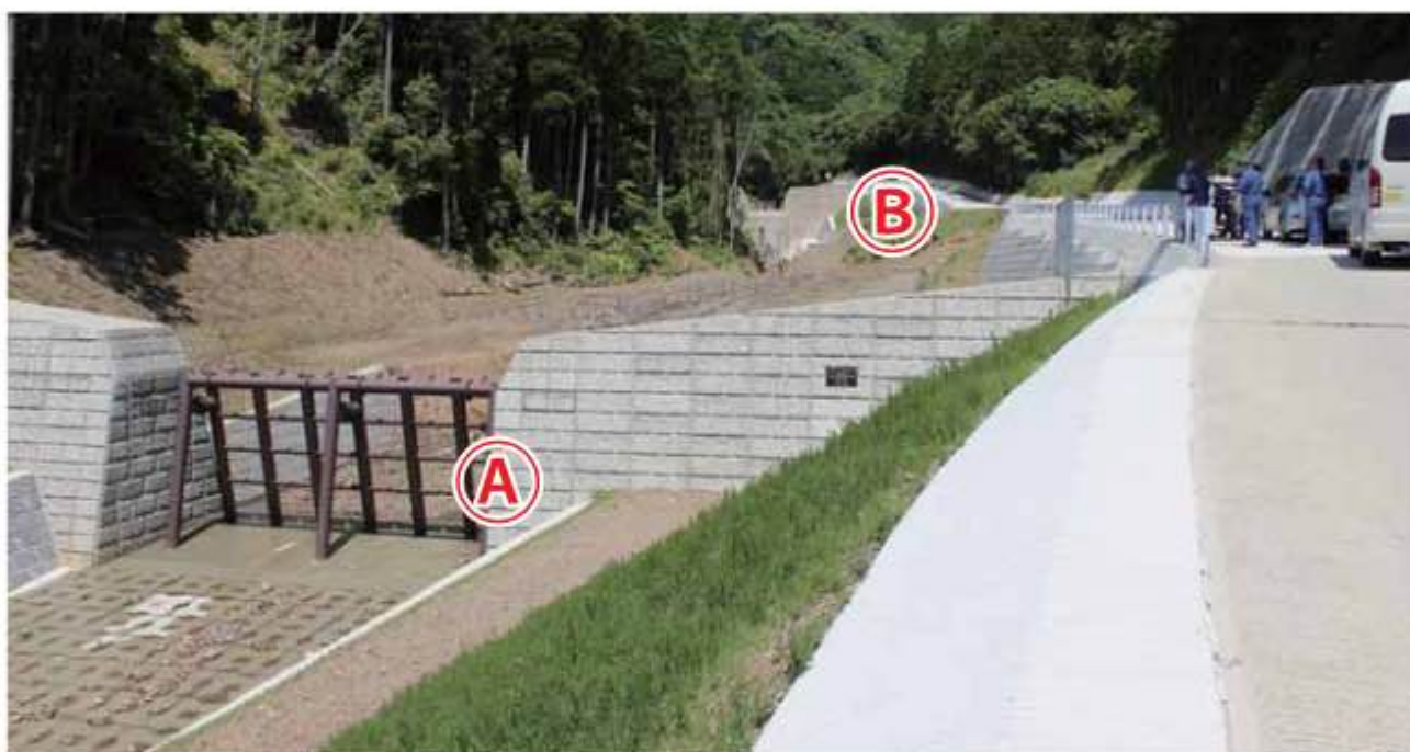
①：新設した砂防ダム（透水型）
