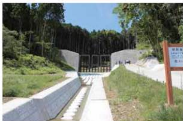
集落から見上げた砂防ダム
