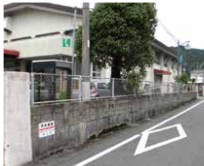
ブロック塀整備前（田浦中）
