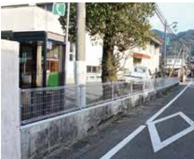
ブロック塀整備後（田浦中）
