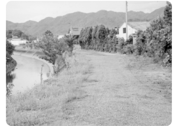
赤松川河口の河川堤防
