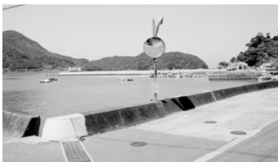
漁港整備工事予定の海浦漁港
