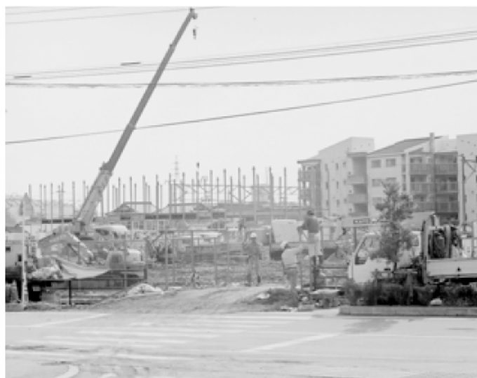
佐敷小学校の仮設校舎造成工事(佐敷駅裏)
