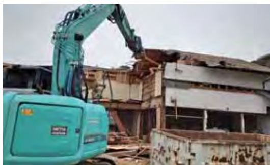
公費解体中の被災住宅
