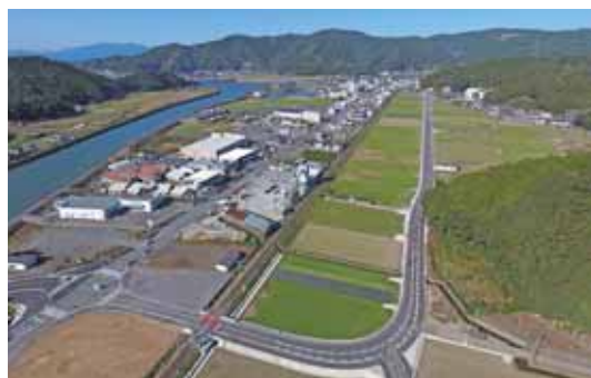
全線開通した【町道射場芦北線】
