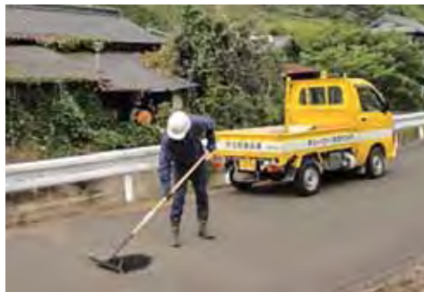
町道を点検し修繕を行う建設課職員
