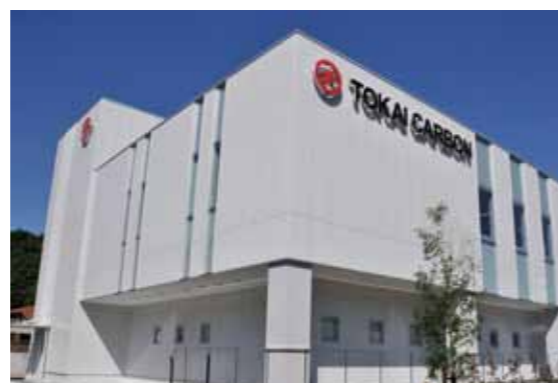
東海カーボン田ノ浦工場の事務・厚生棟が落成（10月15日）
