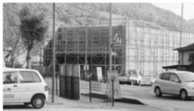
追加補正された工事中の星野富弘美術館 (5月13日オープン予定)
