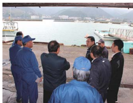
浚渫予定の田浦漁港
