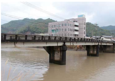
補修予定の山崎橋
