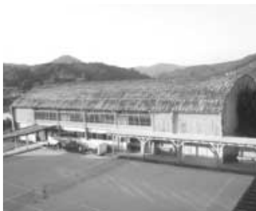
来年度、改築予定の湯浦中体育館
