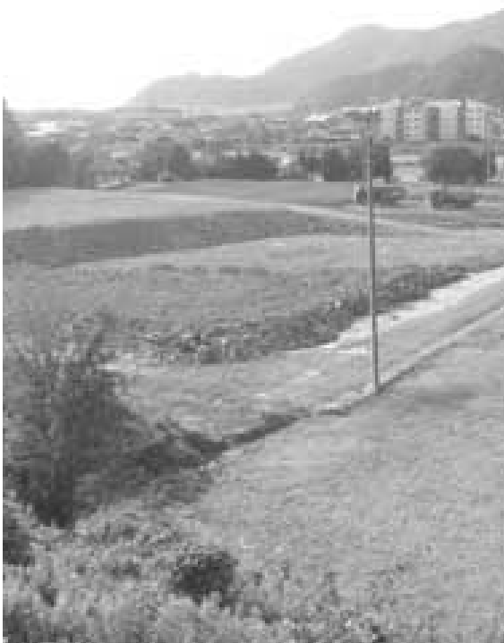
工事が進む芦北総合グラウンド
