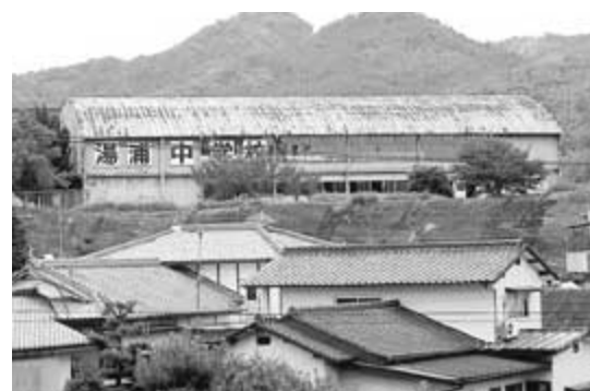
湯浦中学校体育館
