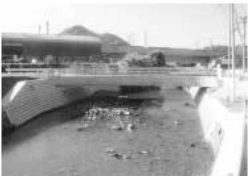
竣工した与内越橋（田川地区）
