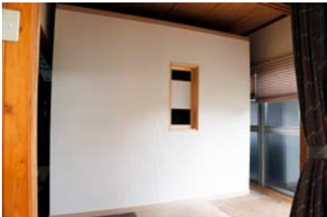
▲耐震シェルター側面 既製品のため上部や側面に空きスペースができるが、設置費用は安く抑えることができる
