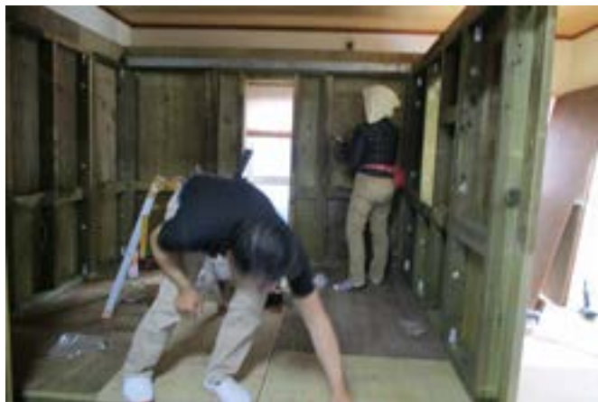
▲施工中の様子 耐震シェルターとは居間や寝室を補強し安全な空間を確保するもの
