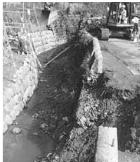
矢風川河川災害復旧工事(市野瀬)
