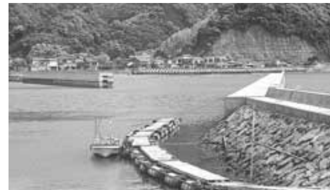
工事の変更があった海浦漁港改修工事
