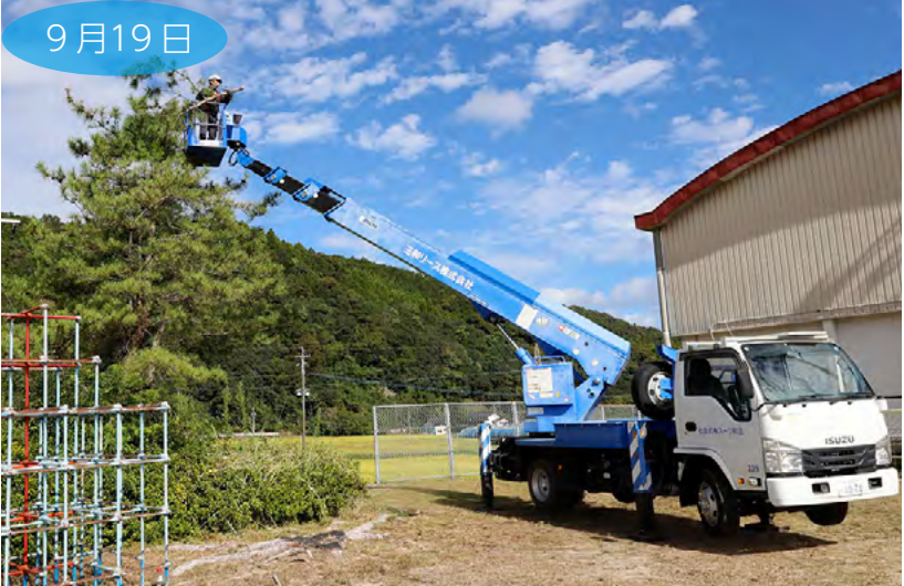
▲高所作業車を借りてきて樹木の伐採を行う熊本県建設業芦北支部組合員
