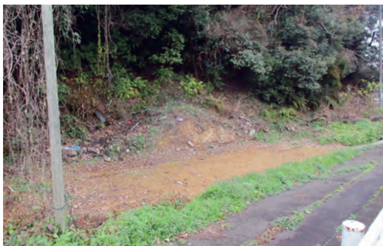
危険家屋解体後
