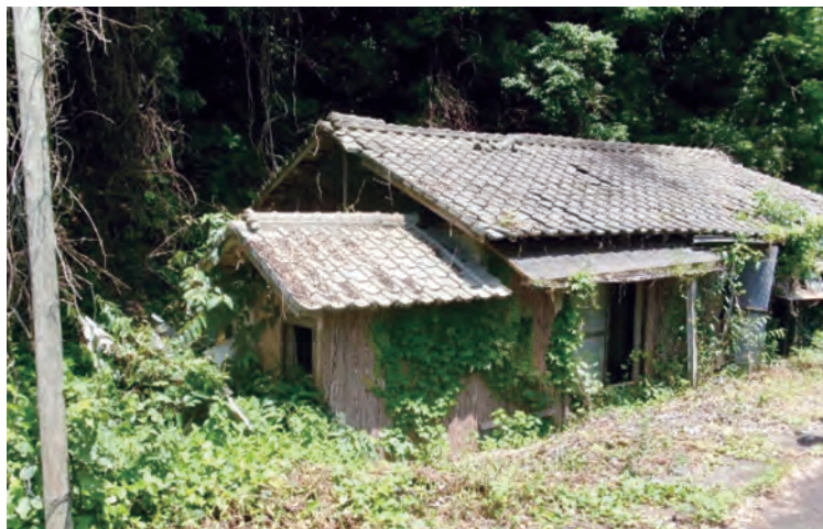
危険家屋解体前
