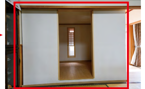
▲既存の住宅に耐震シェルターを設置（赤枠部分） （※本町における施工事例）
